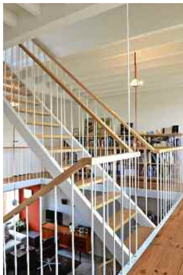
De trap is een knap stukje design. Door de stijlen te laten doorlopen in de borstwering lijkt hij de volledige verdieping te omarmen.
